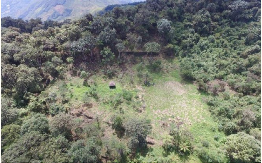
Figura 2. Fotografía del sector incaico compuesto por la plaza y las estructuras ortogonales, tomada desde el aire con el uso de dron.
